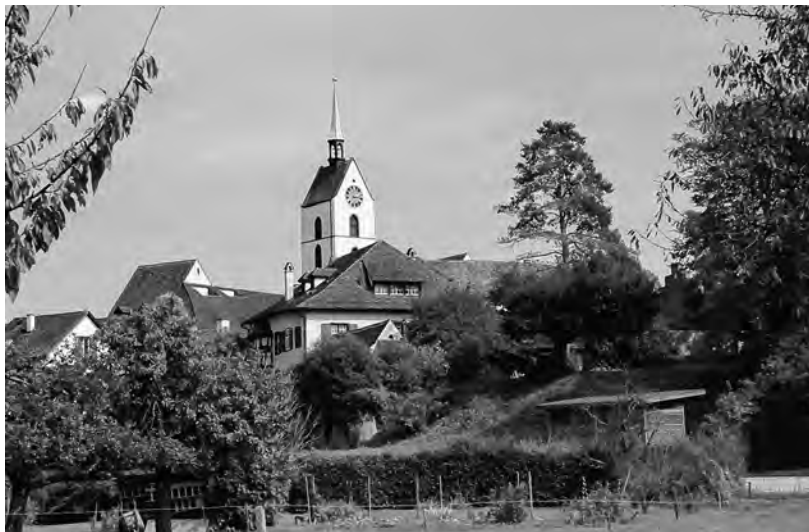
Landvogtei Riehen mit anschliessender Hangkante
