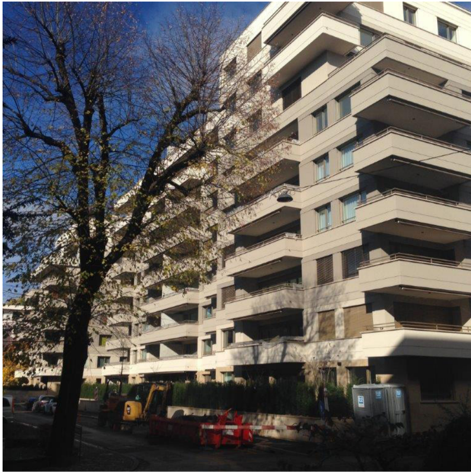
Abb. 3 // Lautengartenstrasse 9-13/Ecke Malzgasse
