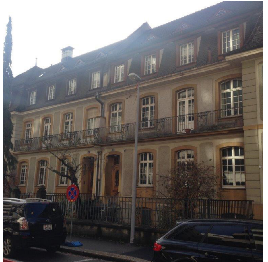
Abb. 4 // Lautengartenstrasse, gegenüberliegende Strassenseite
